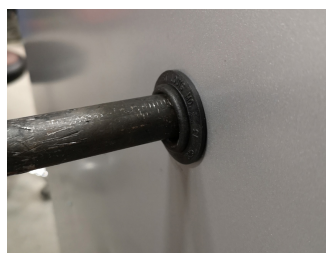
Figure 27. Raccordements de la conduite de gaz de la fournaise (notez l'anneau en caoutchouc)
